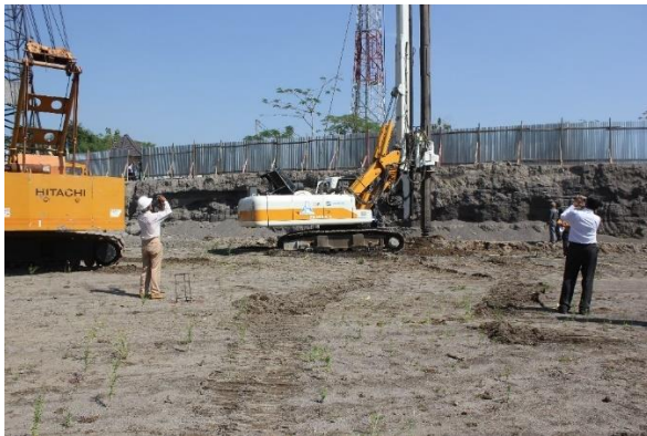
Proses pembuatan pondasi bore pile untuk pondasi Tower Nakula dan Sadewa.
