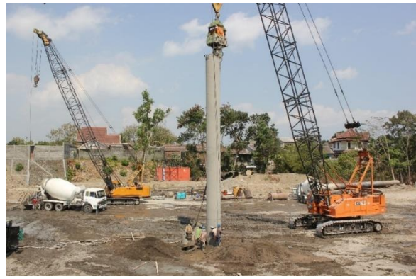
Proses pembuatan pondasi bore pile untuk pondasi Tower Nakula dan Sadewa.
