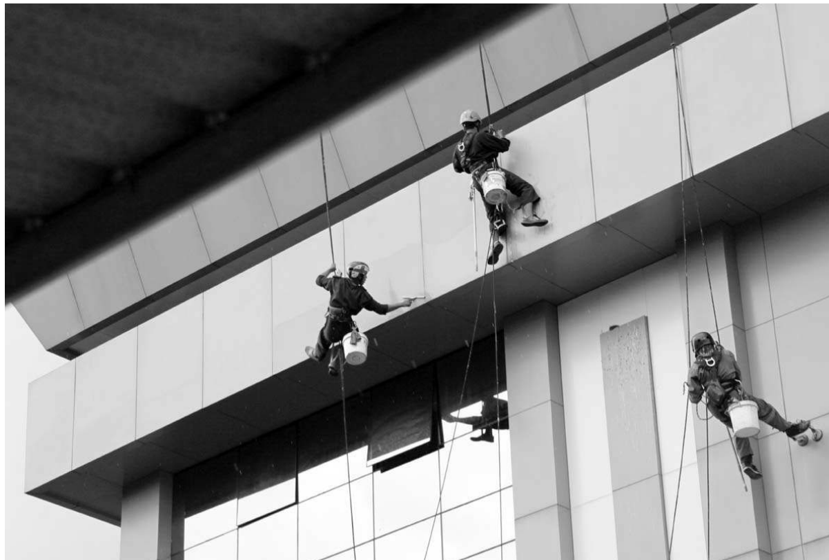
PEKERJA INFORMAL DI INDONESIA : Tiga pekerja membersihkan dinding salah satu gedung di Kabupaten Bogor, Jawa Barat, Rabu (27/11/2024). Badan Pusat Statistik (BPS) mencatat jumlah pekerja yang bekerja pada kegiatan informal pada Agustus 2024 sebanyak 83,83 juta orang atau 57,95 persen, sedangkan yang bekerja pada kegiatan formal sebanyak 60,81 juta orang atau 42,05 persen.
