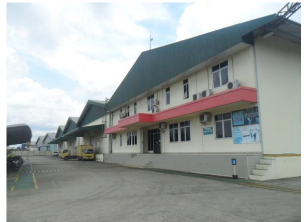
Nama : Pergudangan Tembesu no 1 Lokasi : Tembesu Palembang Luas Tanah : 7.502 m2 Luas Bangunan : 4.368 m2 Penyewa : PT. Tigaraksa Satria Tbk.
