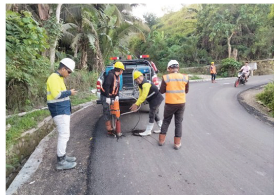
Infrastruktur: Perbaikan jalan desa yang rusak di sekitar Dusun Hele, Desa Hulawa.
